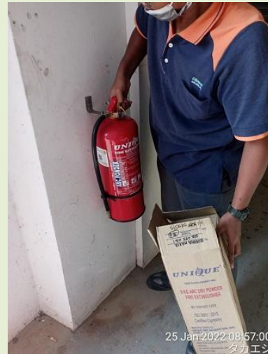
Penggantian alat pemadam api yang expired
